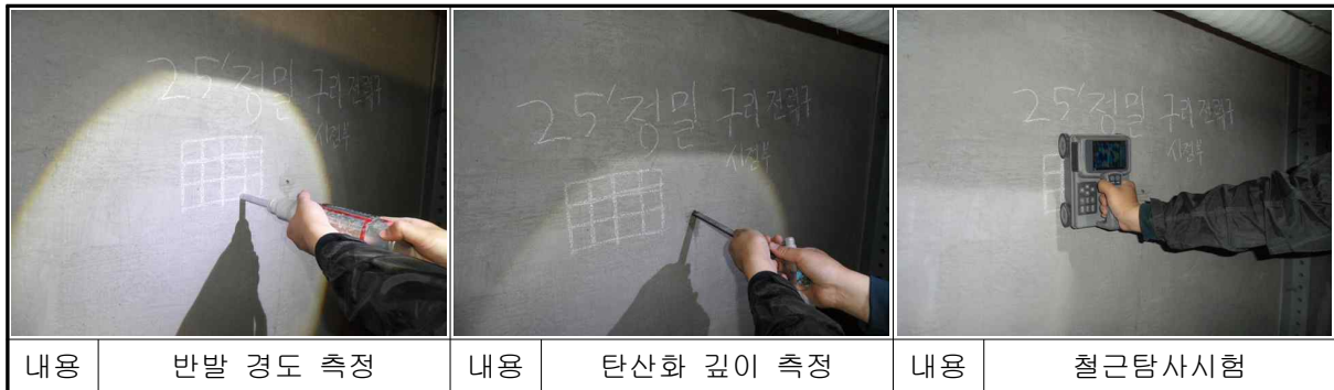
【사진 1.5】 구리인출 전력구 재료시험 전경
